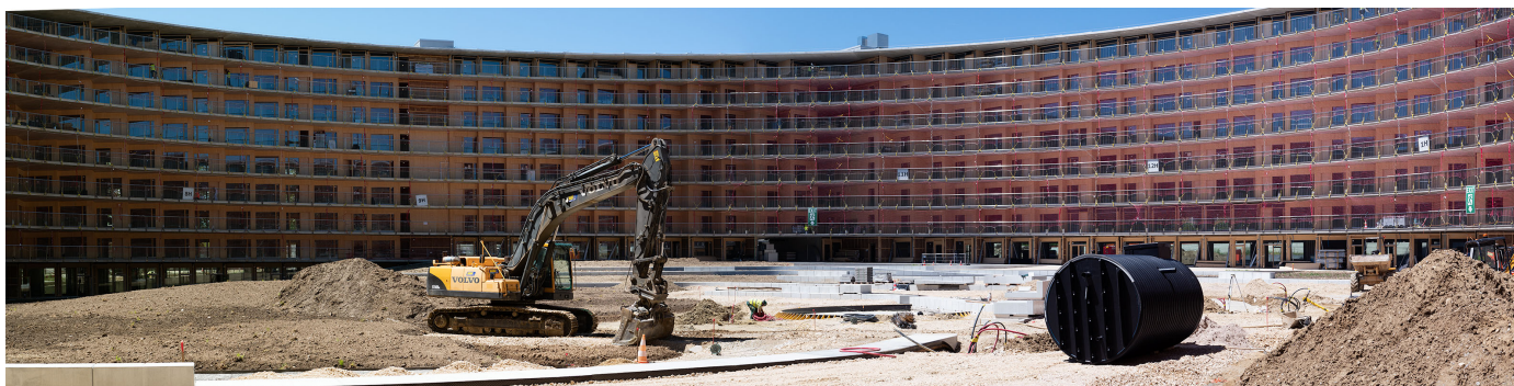
Vue de l'espace intérieur, d'une surface de 8600m 2
