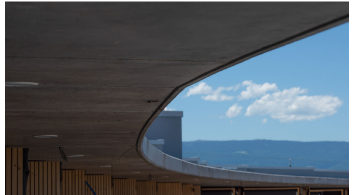
Vue de la rampe au niveau de la toiture
